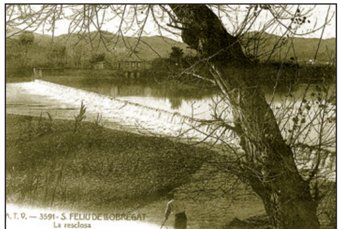
Presas en el Llobregat a la altura de Sant Feliu
