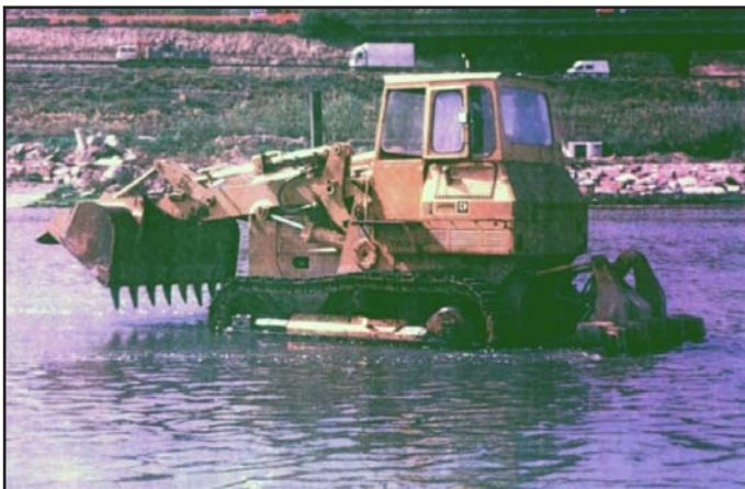
Tractor con ripper realizando tareas de escarificación del lecho del río..
