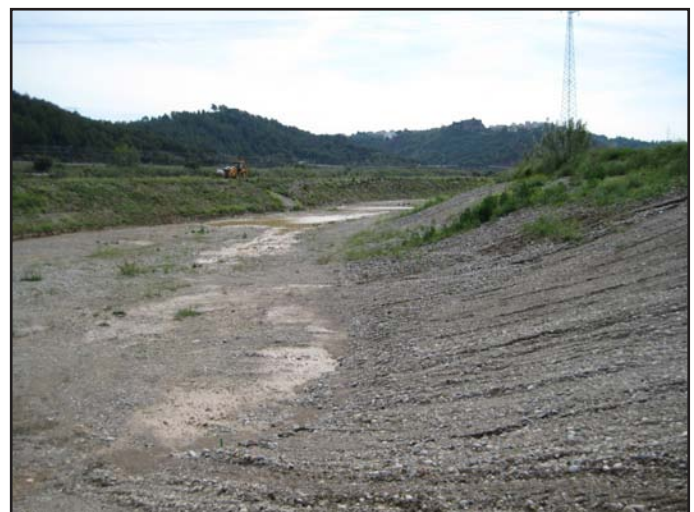
Vista de la balsa de infiltración de Castellbisbal
