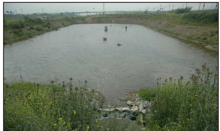
Vista de la balsa de infiltración de Sant Vicenç dels Horts durante la fase de pruebas (Vall Baixa del Llobregat)
